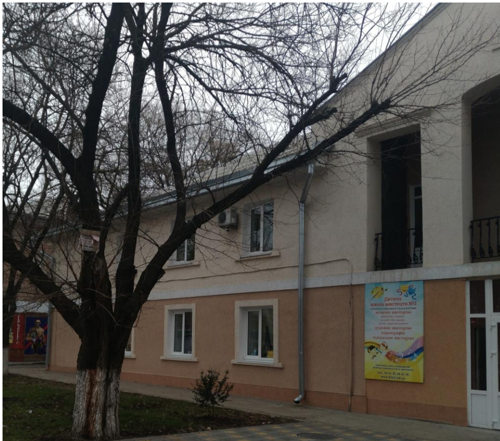
Фото ФФ№5 (загальний вигляд, фасад по осі Е)
