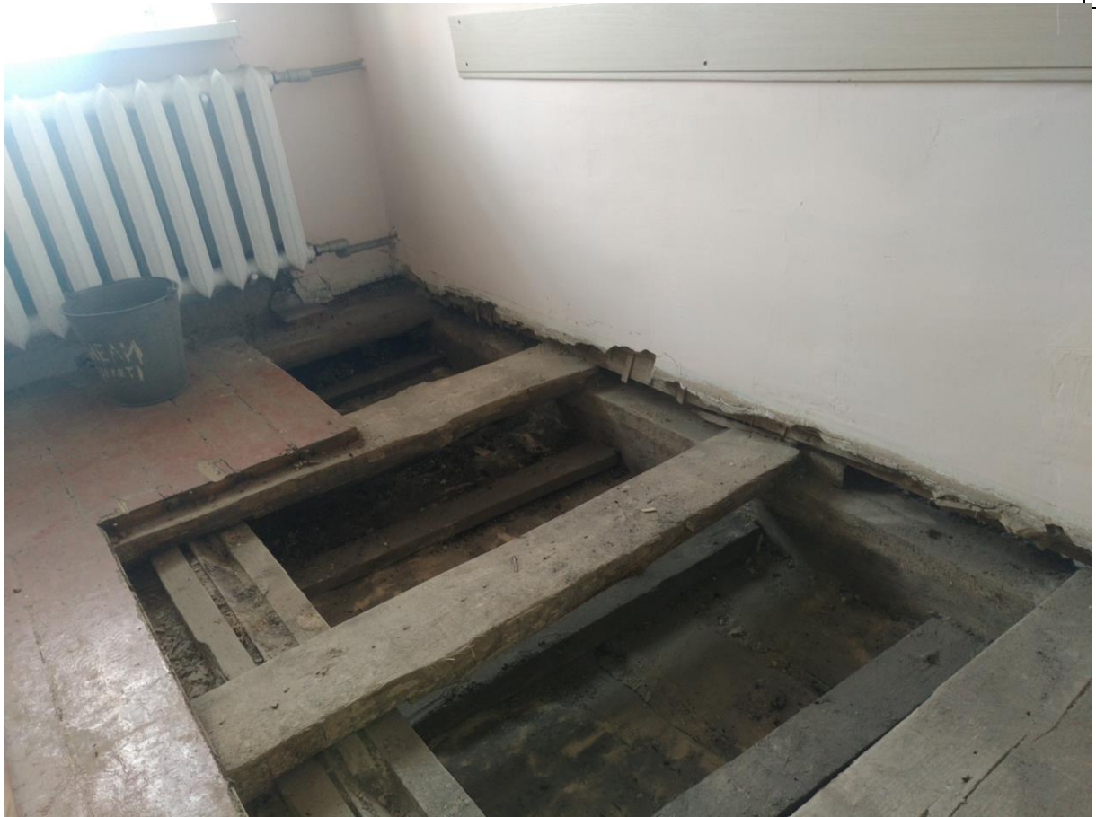
Фото ФФ№24 (розтин дерев'яного балочного перекриття першого поверху першого блоку будівлі)
