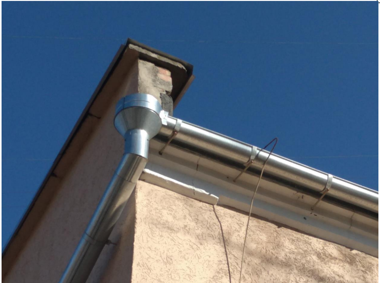
Фото ФФ№20 (локальне замокання парапету другого блоку будівлі)
