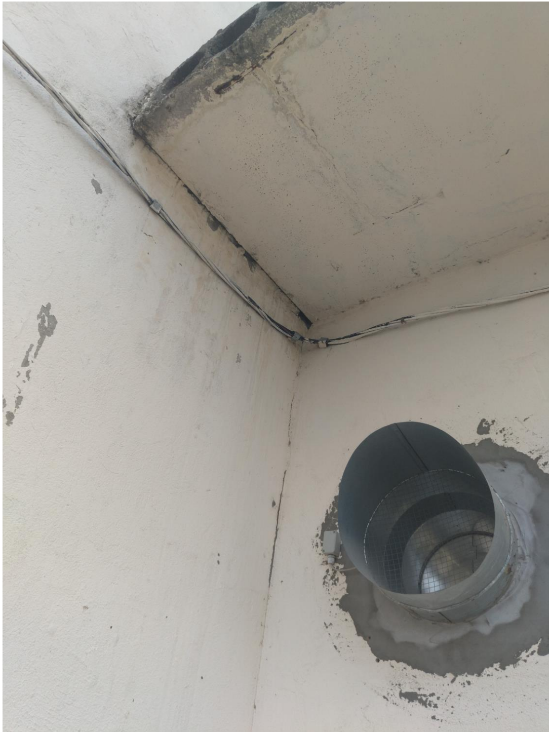
Фото ФФ№16 (тріщина між вставкою та другим блоком будівлі по дворовому фасаду)
