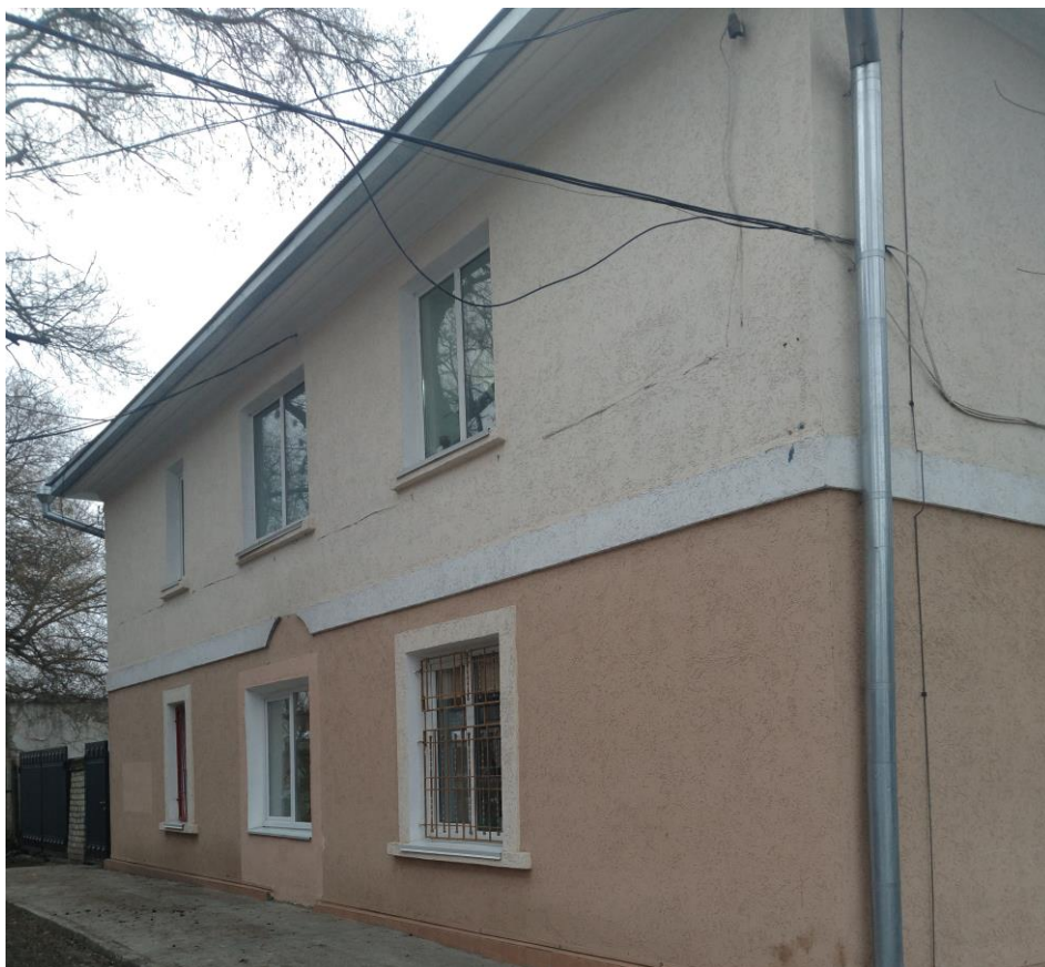
Фото ФФ№6 (загальний вигляд, фасад по осі 10)
