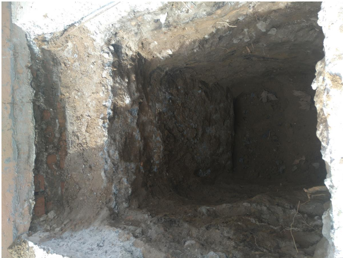
Фото ФФ№12 (Шурф №4)
