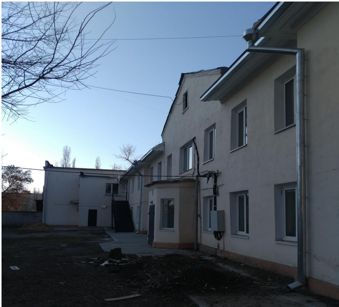
Фото ФФ№8 (загальний вигляд, фасад по осі В)
