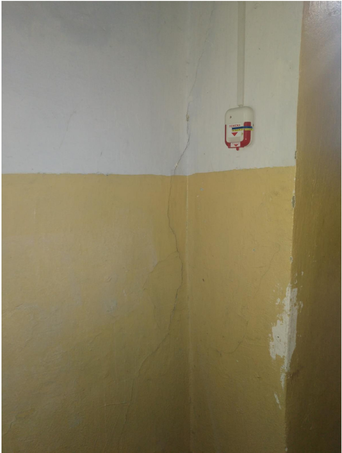
Фото ФФ№19 (наскрізна тріщина в зовнішній стіні)
