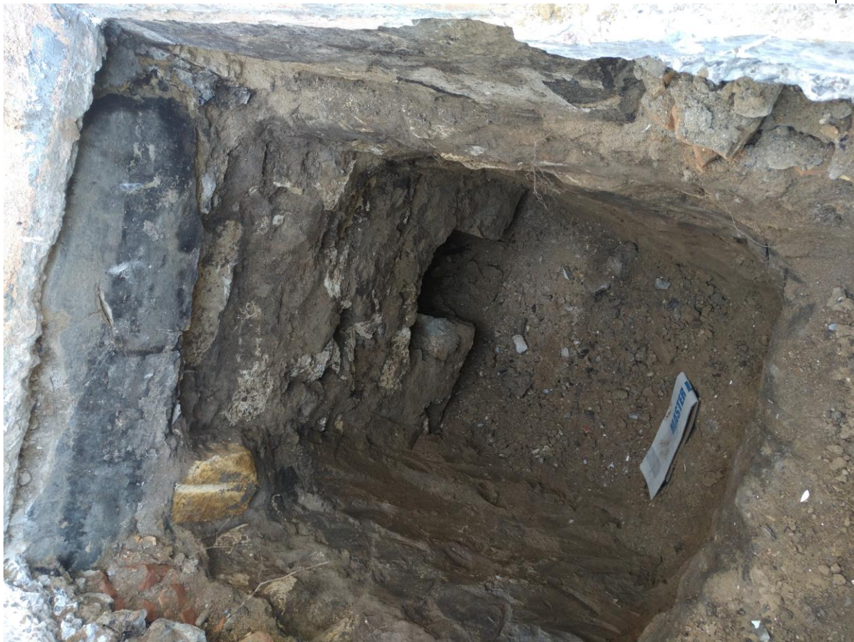
Фото ФФ№10 (Шурф №2)
