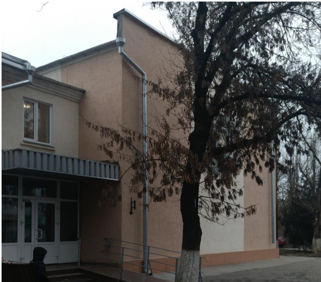
Фото ФФ№3 (загальний вигляд, фасад по осі Ж)
