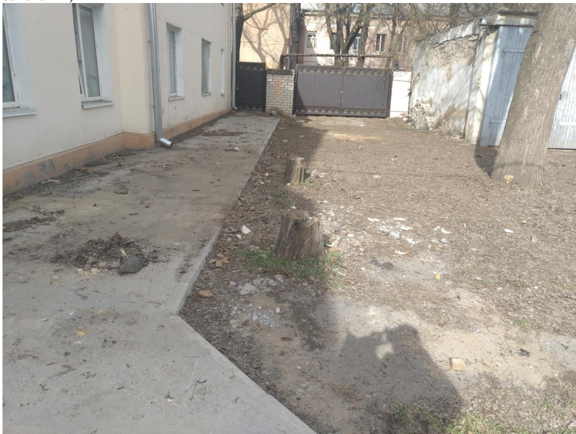
Фото ФФ№18 (рівень вимощення вище планувальної з ямами локального замокання)
