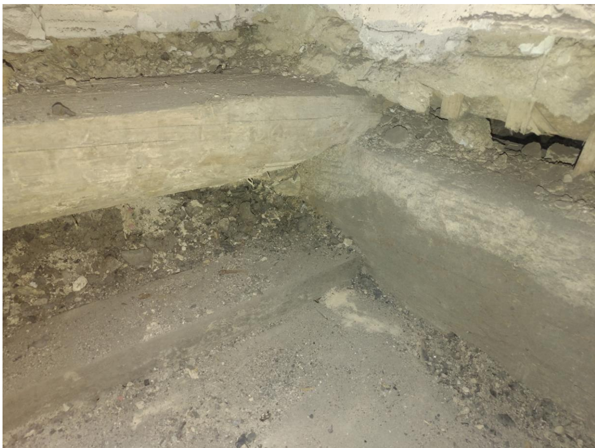
Фото ФФ№23 (розтин дерев'яного балочного перекриття першого поверху першого блоку будівлі)
