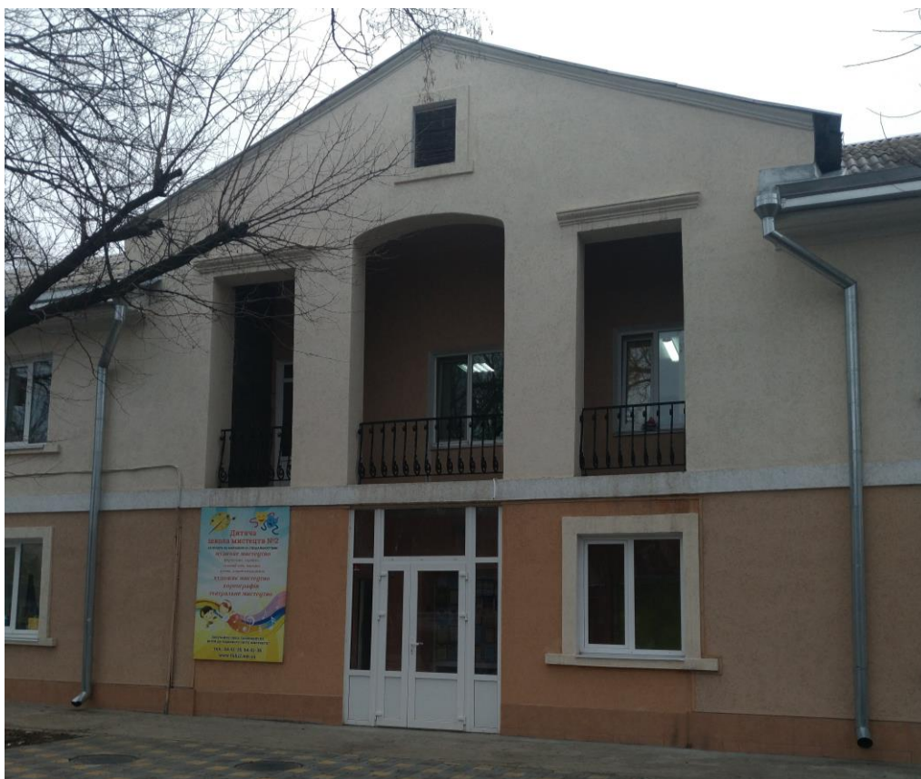
Фото ФФ№4 (загальний вигляд, фасад по осі Е)
