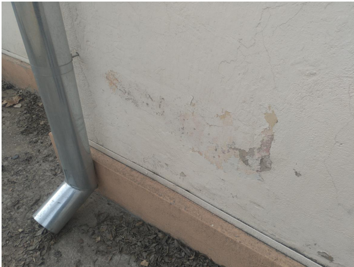
Фото ФФ№17 (початкова стадія відшарування штукатурки по фасаду осі В при локальному замоканні )
