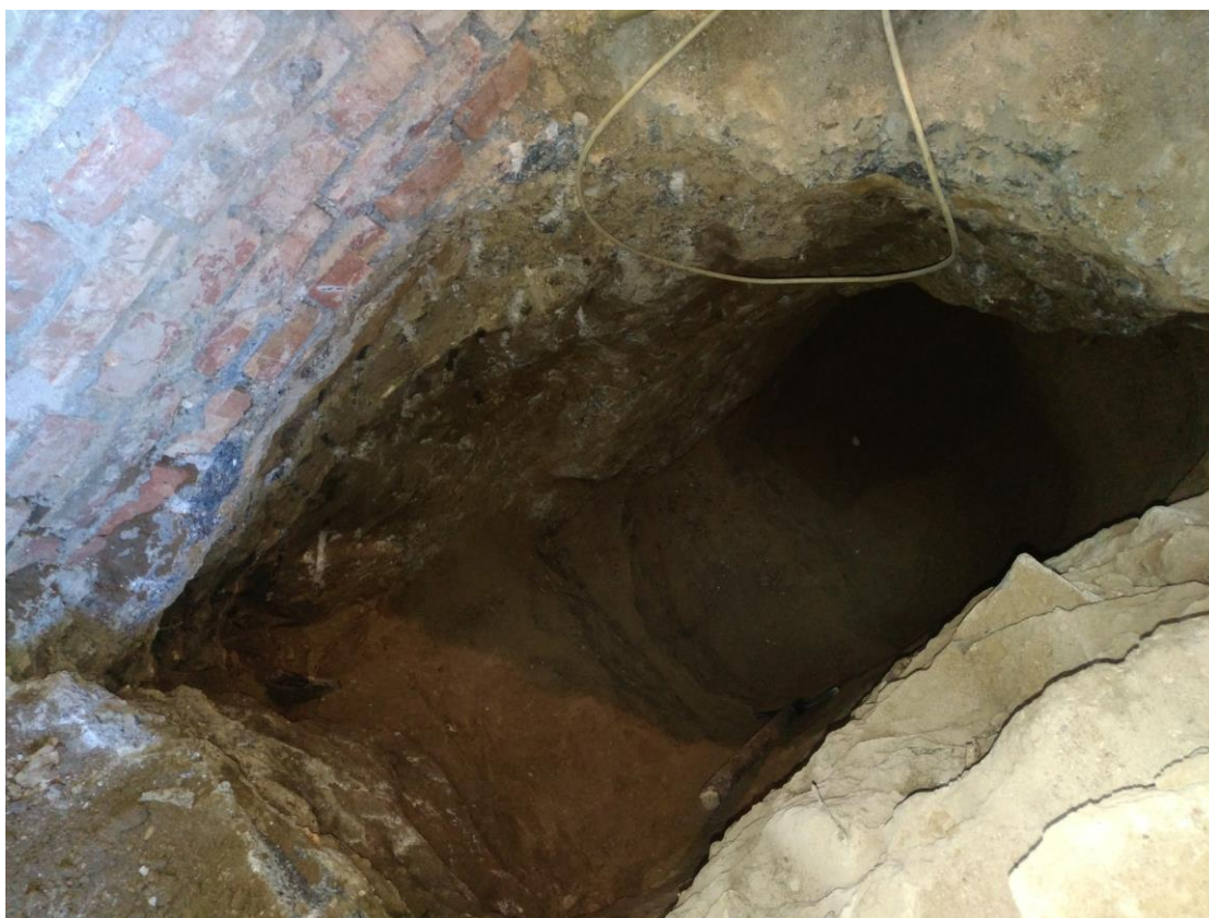
Фото ФФ№11 (Шурф №3)
