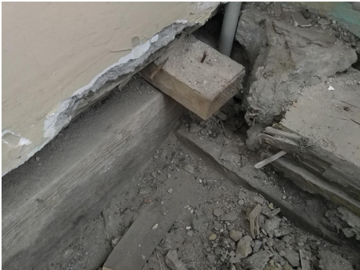
Фото ФФ№22 (розтин дерев'яного балочного перекриття першого поверху першого блоку будівлі)
