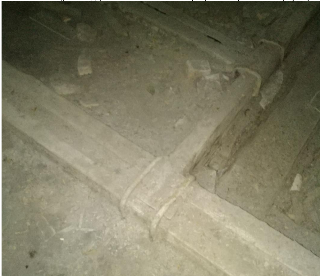
Фото ФФ№25 (дерев'яне балочне перекриття над другим поверхом першого блоку будівлі)
