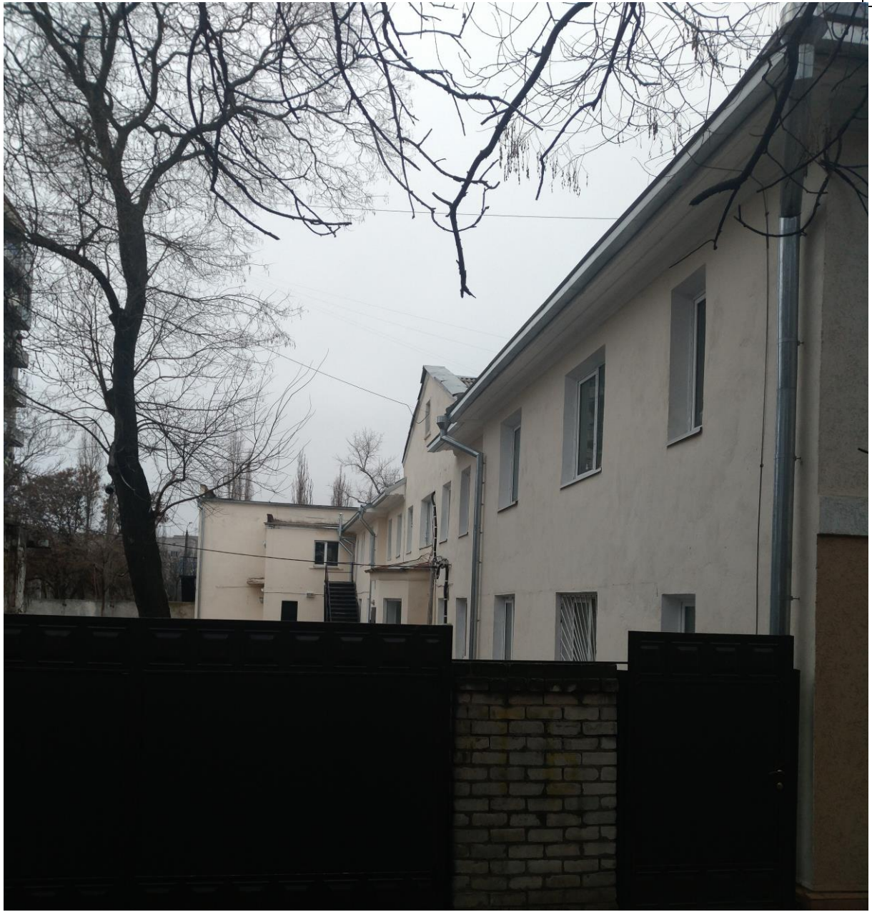
Фото ФФ№7 (загальний вигляд, фасад по осі В)
