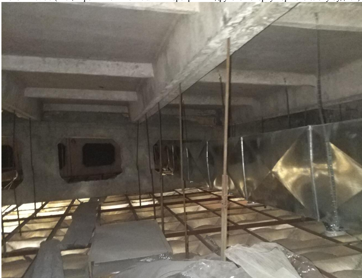
Фото ФФ№31 (конструкції підвісної стелі над актовою залою другого блоку будівлі)
