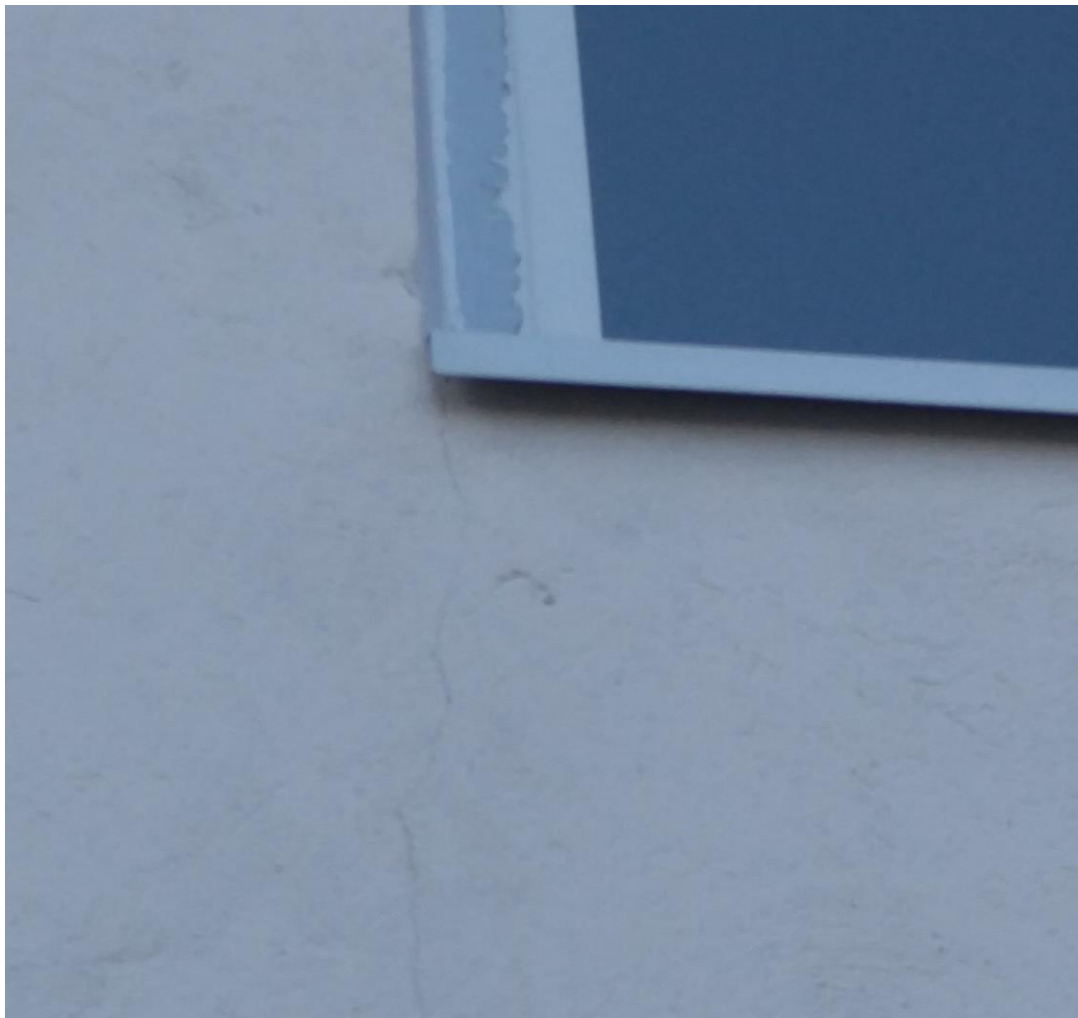
Фото ФФ№13 (поверхнева тріщина у зовнішній стіні в підвіконній частині)
