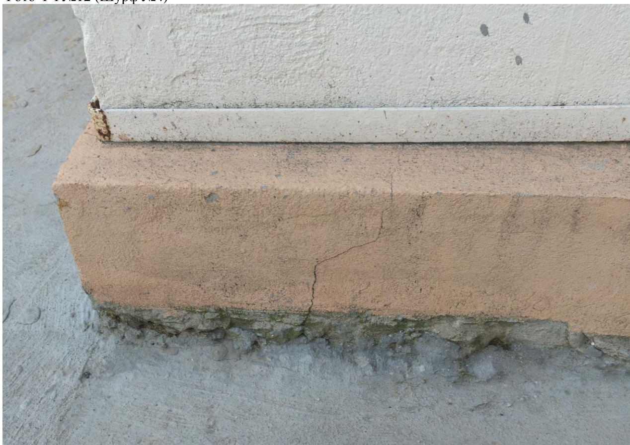
Фото ФФ№12* (поверхнева тріщина у зовнішній стіні на рівні цоколя)
