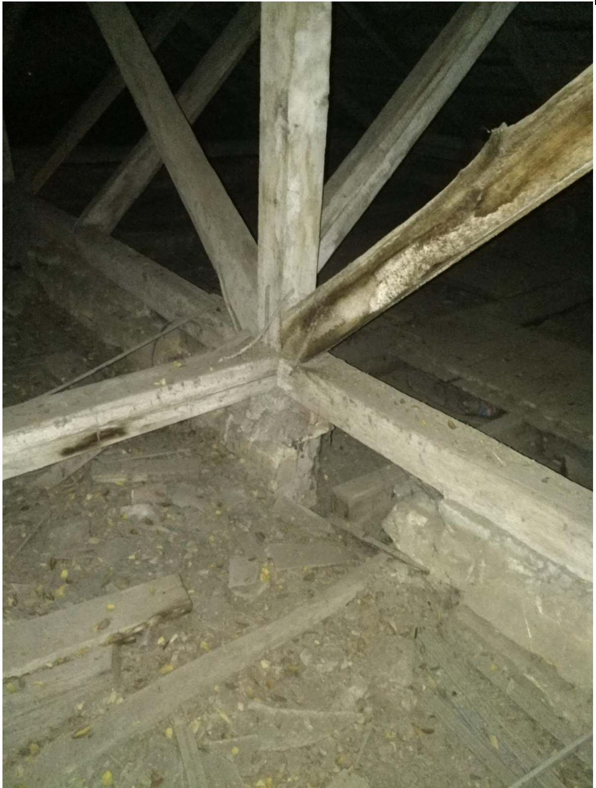
Фото ФФ№27 (зруйнована опорна частина під конструкцією даху, місця ураження гниллю конструкцій першого блоку будівлі)
