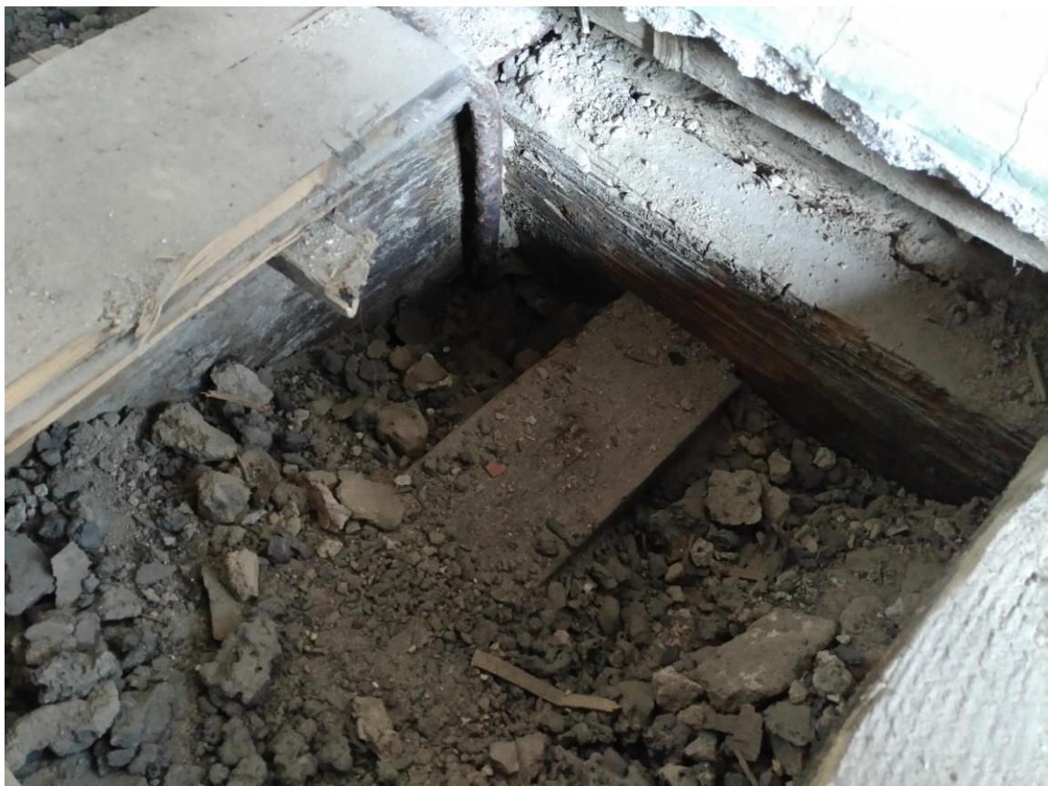
Фото ФФ№21 (розтин дерев'яного балочного перекриття першого поверху першого блоку будівлі)
