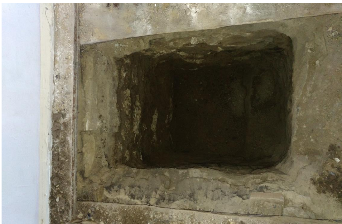
Фото ФФ№9 (Шурф №1)
