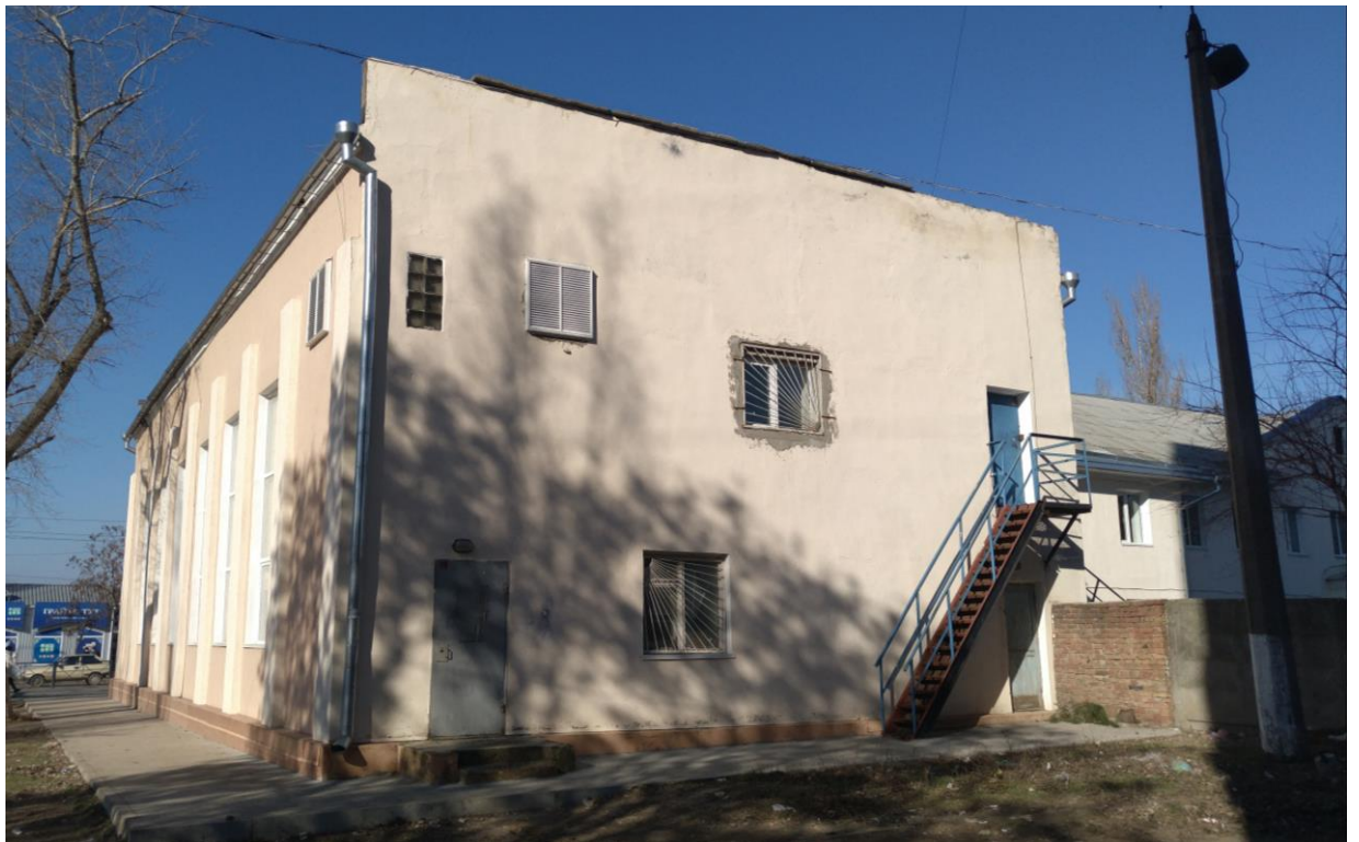
Фото ФФ№2 (загальний вигляд, фасад по осі А)
