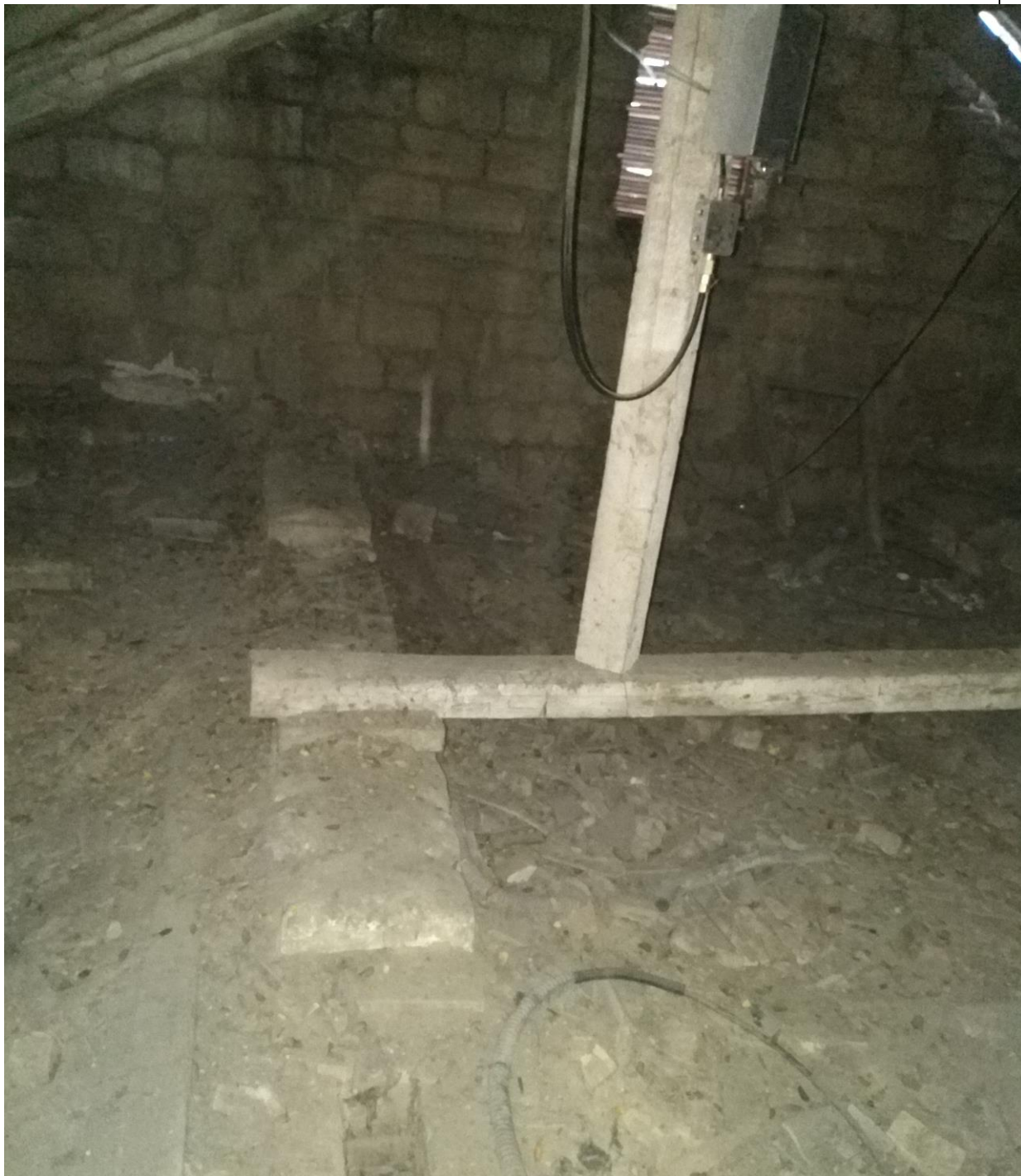
Фото ФФ№28 (підпора в прольотній частині балки конструкції даху з прогином першого блоку будівлі)
