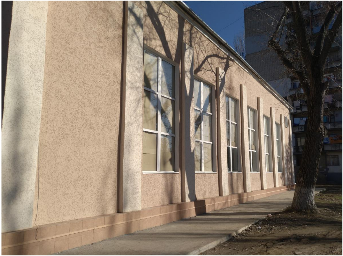
Фото ФФ№1 (загальний вигляд, фасад по осі 1)
