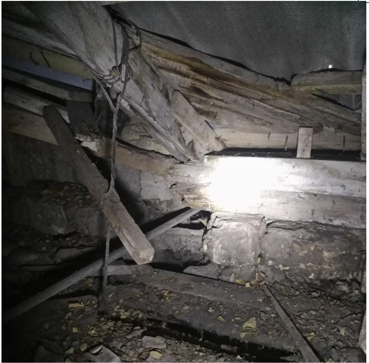
Фото ФФ№29 (руйнування конструкцій даху та перекриття першого блоку будівлі)
