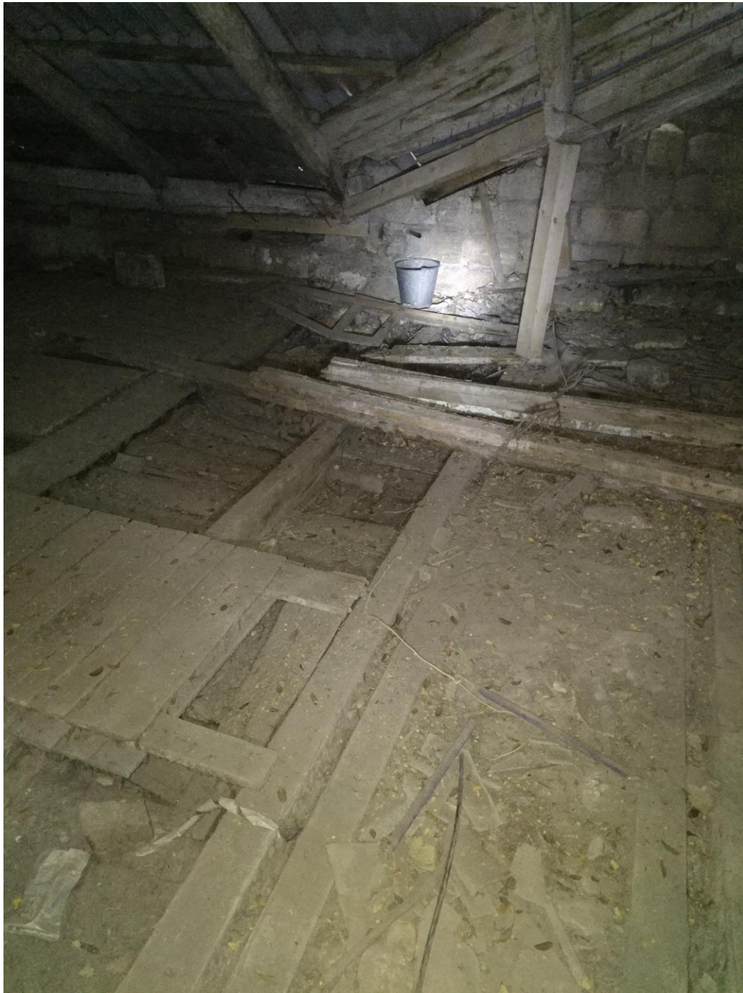
Фото ФФ№26 (локальне замокання в даху першого блоку будівлі)
