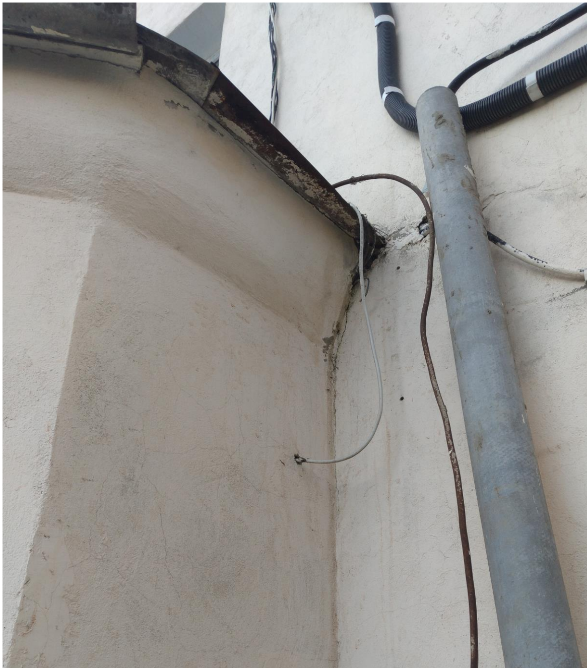
Фото ФФ№15 (тріщина між зовнішньою стіною та тамбуром по осі В)
